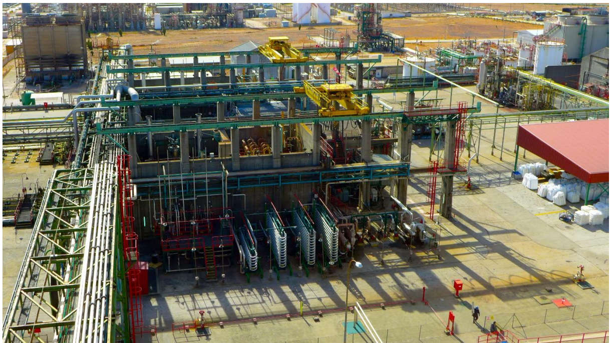
Imagen: Planta EVA/PEBD en el Complejo Industrial de Repsol en Puertollano
