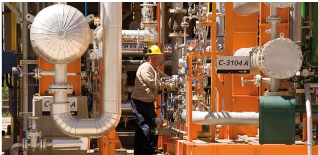
La Plata refinery (Argentina).
